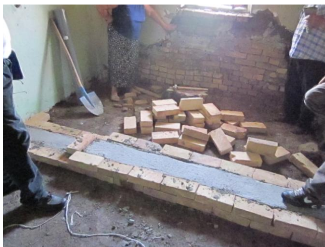
Oplata od cigle - Unutrašnji temelj
