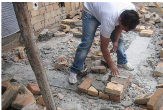
2. U čoškove uvek postavite komade od 3/4 cigle da biste pravilno složili cigle u svakom redu
