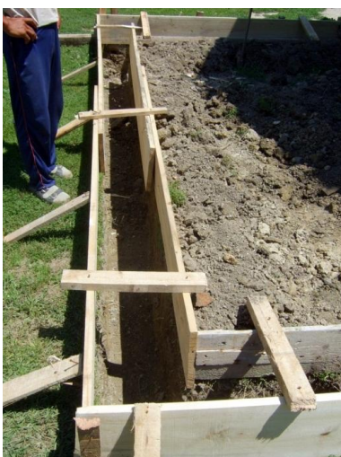
Daščana oplata - Spoljašnji temelj
